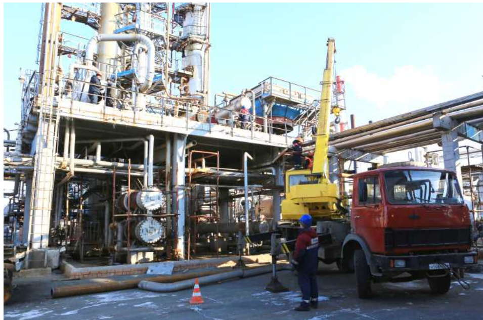
Ведутся работы на блоке очистки газов
