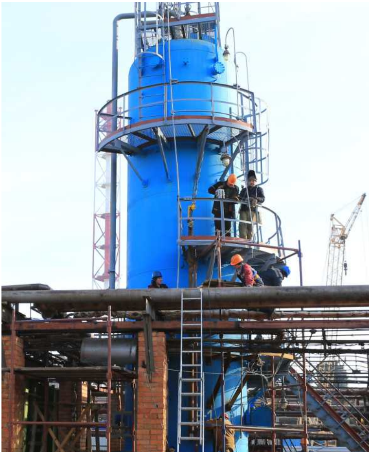
Монтаж выносной камеры волноводного радарного уровнемера
