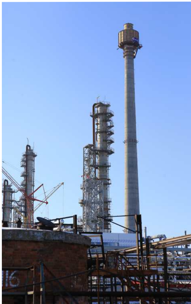
Дымовая труба установки изомеризации
