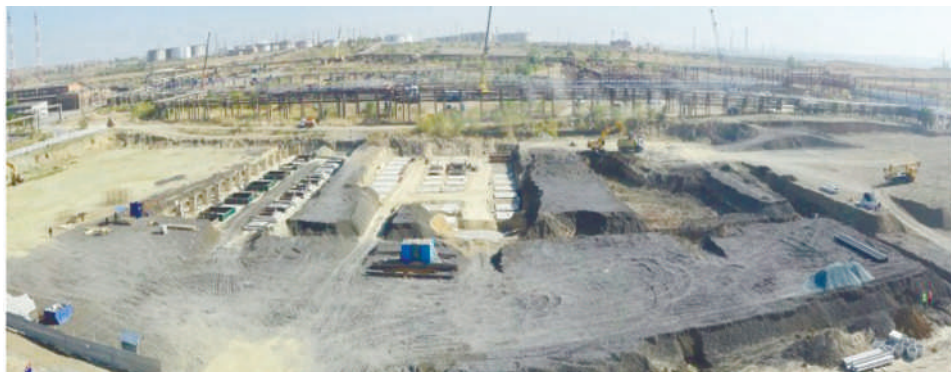
Площадка под строительство установки гидрокрекинга, сентябрь 2015 г.
