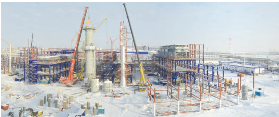
Строительство установки гидрокрекинга, декабрь 2016 г.
