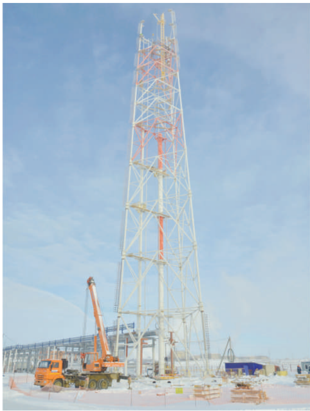
В январе АО «Корта», субподрядная организация АО «Промфинстрой», завершает строительство опорной башни факельной системы установки факельного хозяйства по новой технологии, разработанной специально для Орского НПЗ
