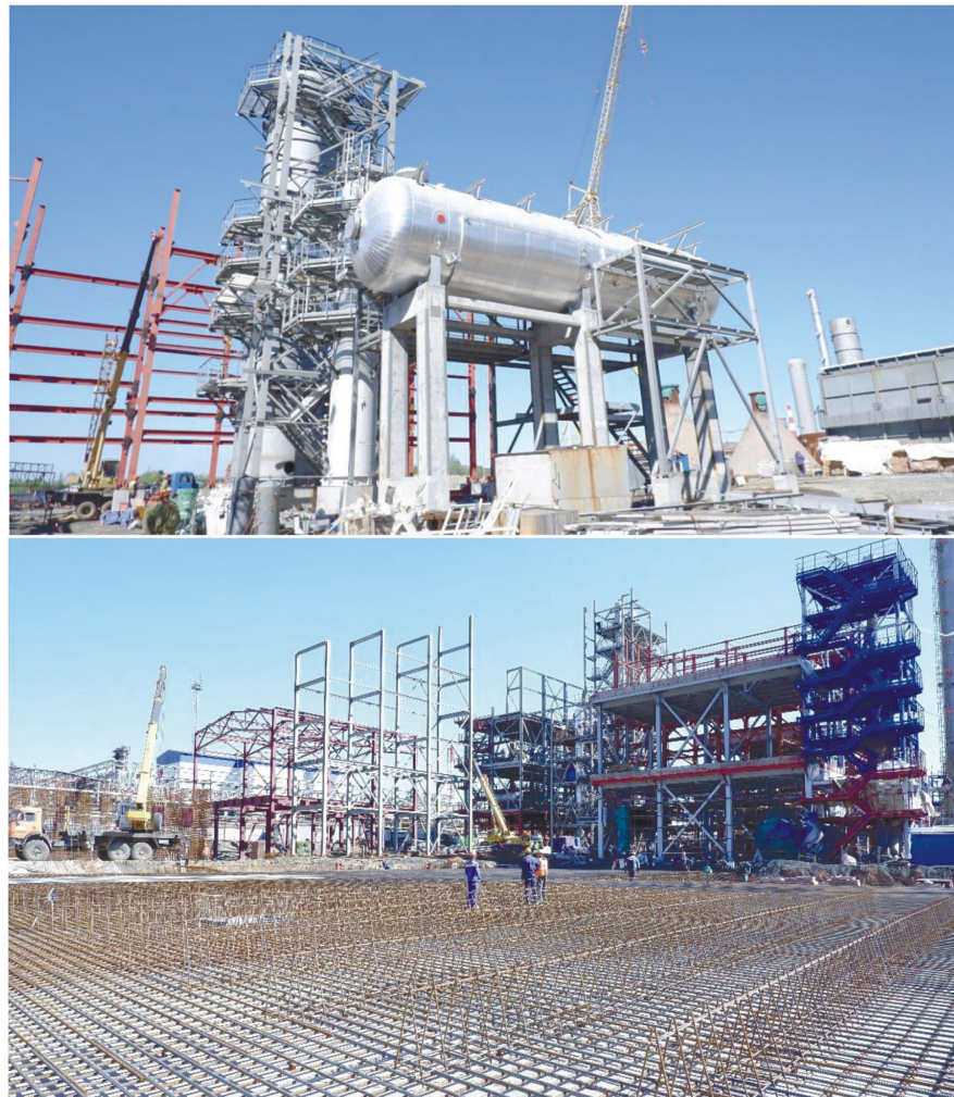
Строительные работы на установке замедленного коксования
