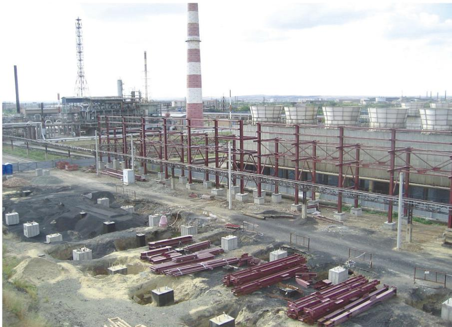
Монтаж межцеховой эстакады Э-210 на установке химводоподготовки №2
