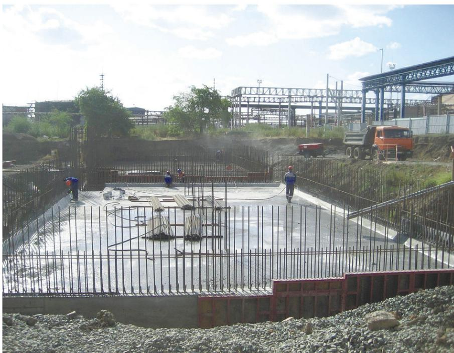
Армирование плиты под резервуар 2/2 на объекте «Резервуары питьевой воды с насосной»
