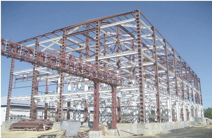
Монтаж металлоконструкций и нанесение огнезащитного состава на здание бытового корпуса
