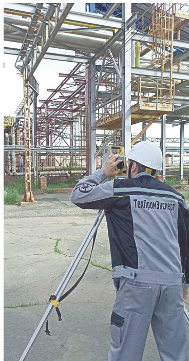
Сотрудник ООО «ТехПромЭксперт» выполняет геодезическую съемку отклонений стоек эстакады от вертикали
