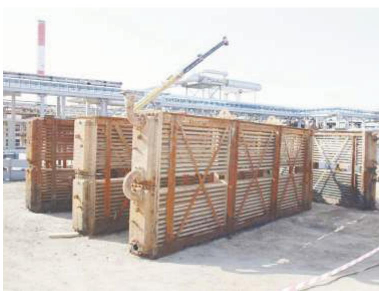
На установке ЭЛОУ-АТ-5 производится замена внутреннего трубного змеевика радиантной и конвекционной камеры печи
