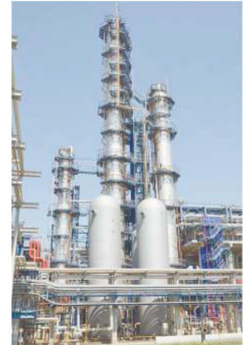
Продукты десорбции выводятся из колонн. Для получения «кипящего» слоя адсорбента в адсорбционных колоннах подается снизу газ. Проходя через решетку, на которой лежит слой мелкораздробленного адсорбента, газ приводит его в псевдожидкое состояние. Адсорбент непрерывно поступает сверху и после отработки удаляется для десорбции.
