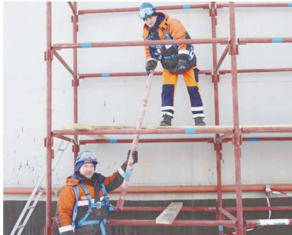
Д.Ларионов и В.Аутин устанавливают строительные леса для ремонта резервуара Р-89
