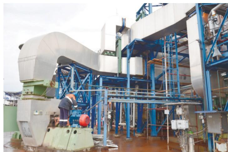
**Н**а установке висбрекинга в ходе плановых ремонтных работ был установлен новый рекуператор — теплообменник Т-13, входящий в состав печи П-01.
