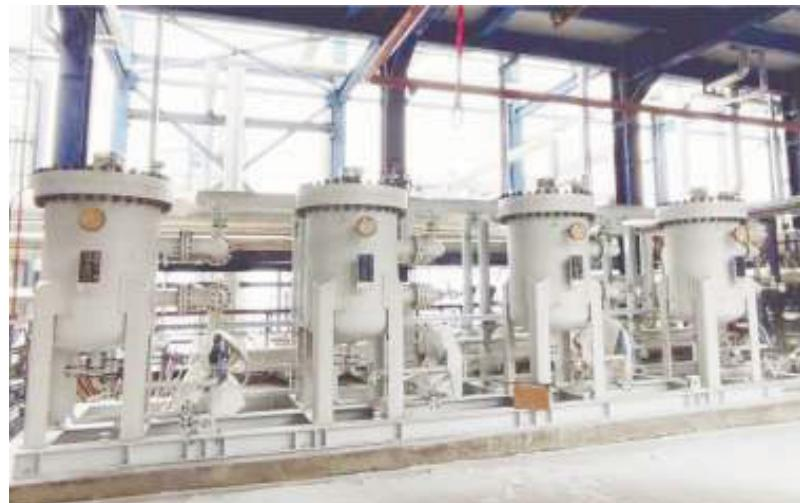
Фильтрующая установка сырья с автоматической системой регенерации
