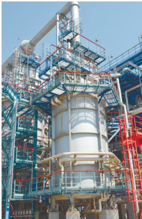
Вертикально-цилиндрическая печь установки изомеризации
