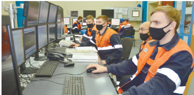
Операторы сразу нескольких установок управляют производственными процессами из объединенной операторной бункерного типа. В рамках Программы модернизации на Орском НПЗ были построены два таких объекта.
