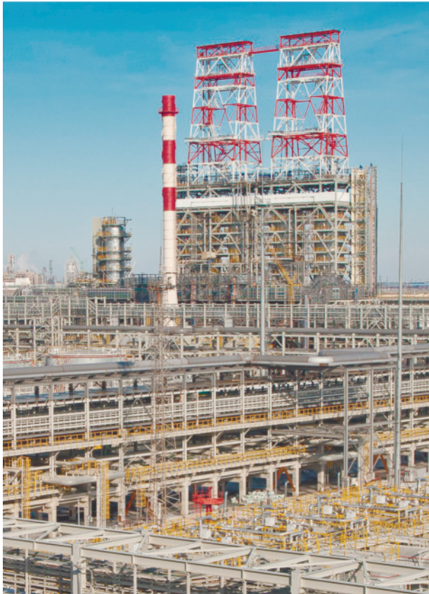
Установка замедленного коксования АО «ТАНЕКО» ГК «Татнефть», построенная по лицензии компании Foster Wheeler USA Corporation
