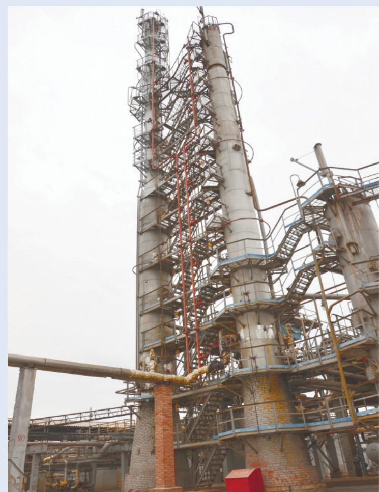
Установки каталитического риформинга предназначены для получения из прямогонных бензиновых фракций компонента высокооктановых бензинов. Достоинство процесса – образование дешевого водородсодержащего газа, необходимого для гидрогенизационных процессов.
