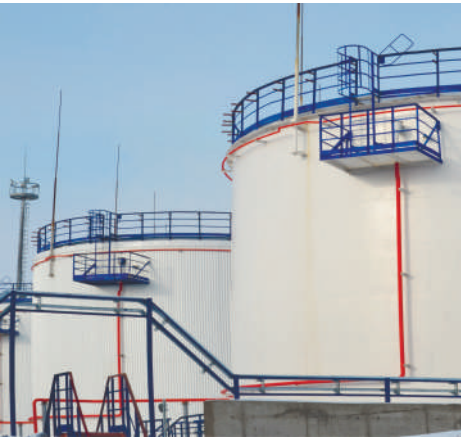
Промпарк установки гидрокрекинга, аналогичные резервуары смонтируют для КЗК
