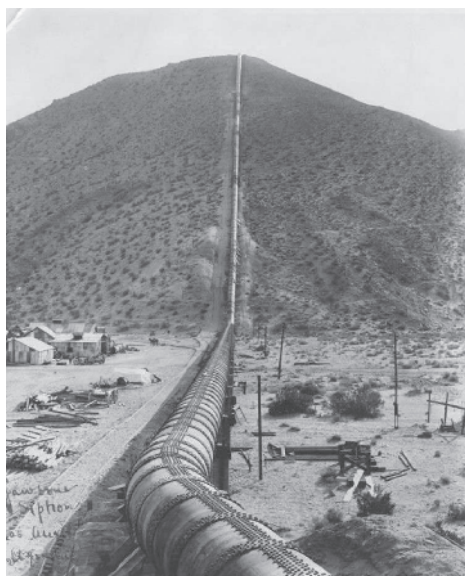
Трубопровод, выполненный при помощи клепочного крепления. США 19 в.
