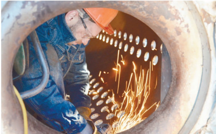
Сотрудник ООО «Сибкотлоресурс» защищает верхний барабан парового котла ДЕ-25-14-225ГМ-О
