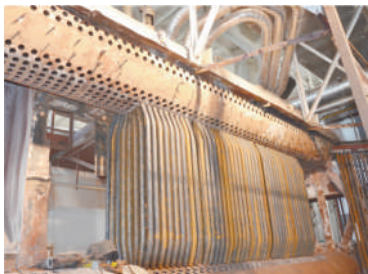
В ходе капитального ремонта была заменена конвективная часть котлов
