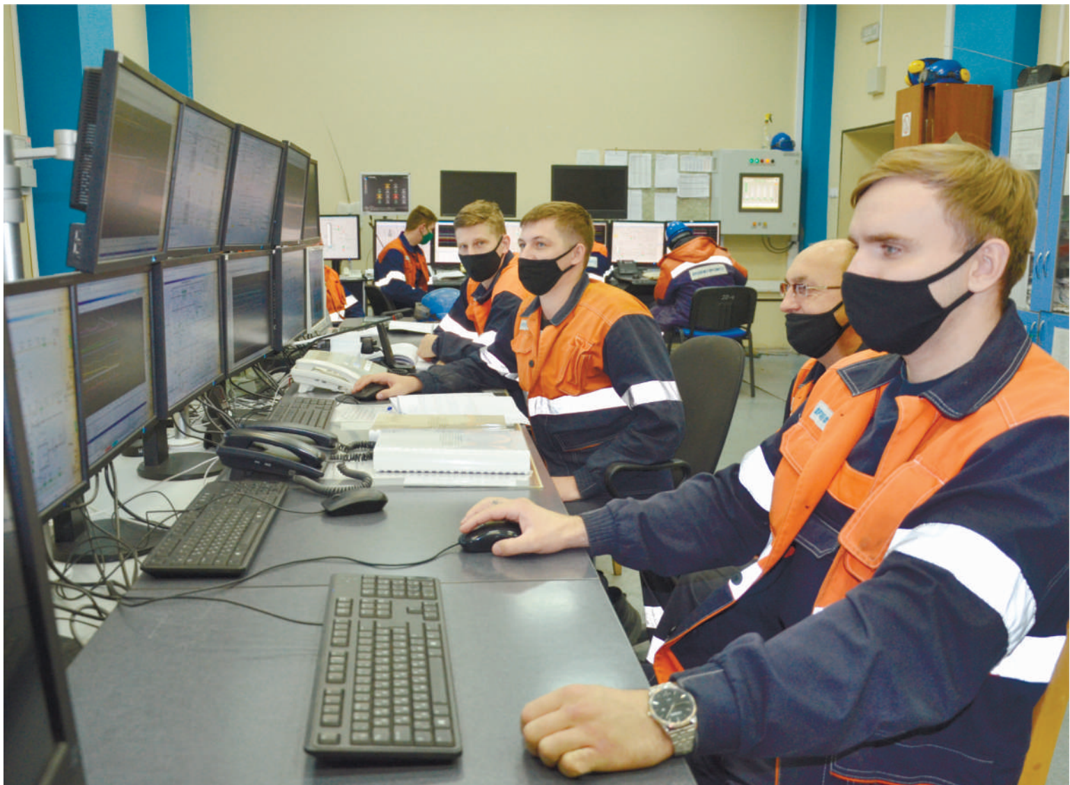
Объединенная операторная установок изомеризации, 22-4М и БРП ПАО «Орскнефтеоргсинтез»
