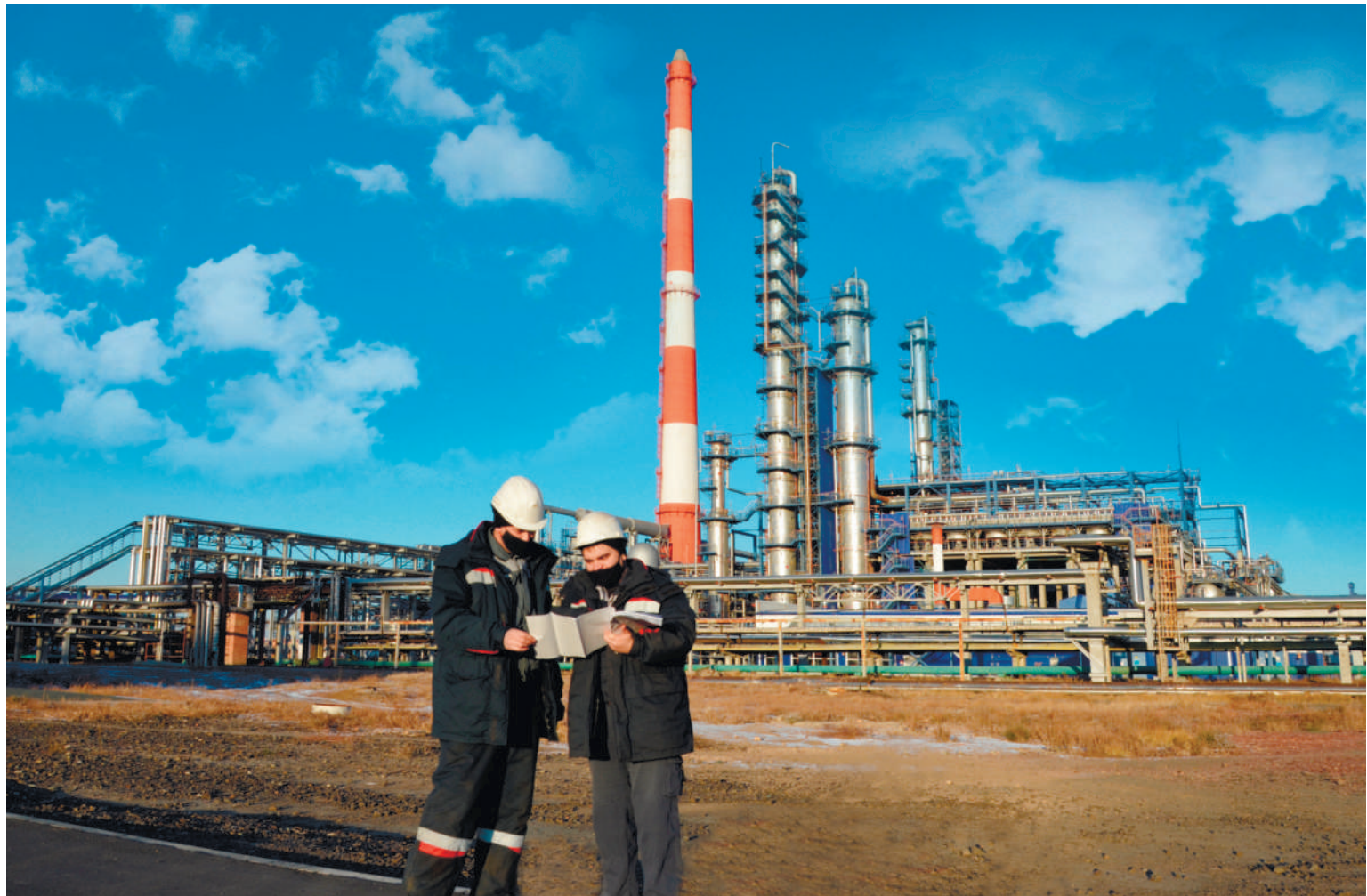
Мастер УМРТО ООО «Строймонтаж» С.В.Фишман и начальник участка И.С.Добрынин обсуждают демонтаж и монтаж емкости Е-10 на установке 22-4М
