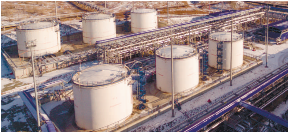
Новый трубопровод предназначен для дренаживания подтоварной воды четырех промышленных резервуаров
