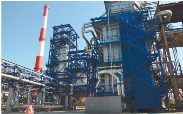
Установка гидроочистки дизельных фракций ЛЧ-24-2000
