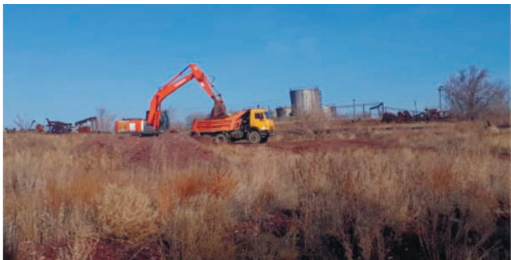
В этом году ООО «ПромСтройМонтаж» выполняло ремонтные работы в цехе №10
