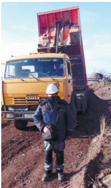
А.Д.Юрков - мастер строительно-монтажных работ ООО «Промстроймонтаж»
