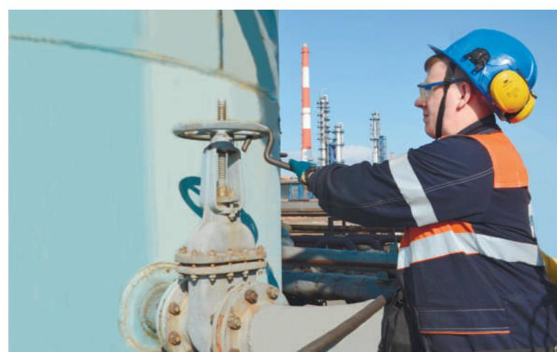
Оператор установки ЭЛОУ-АТ-5 М.В.Бондарь собирает технологическую схему откачки прямогонного бензина с установки
