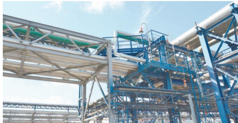
Подвод трубопроводов оборотной воды к водоблоку цеха №5
