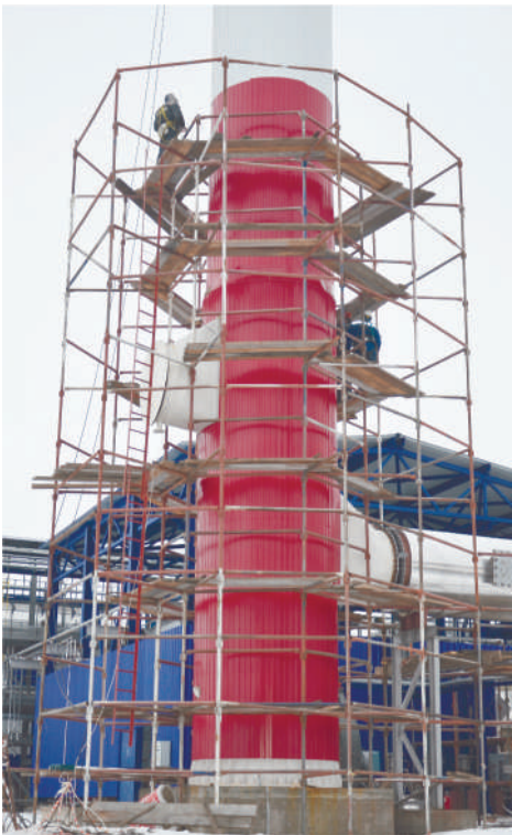
Завершен монтаж дымовой трубы ПК №2
