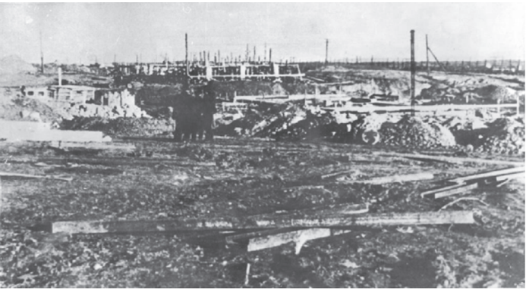
Пустырь, на котором началось строительство Орского НПЗ
