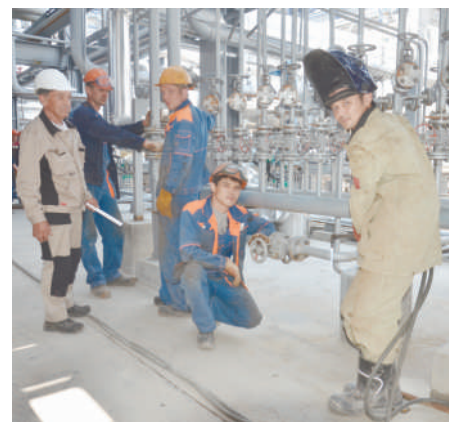
Сотрудники ООО «Прометей» ведут работы на УВПМ
