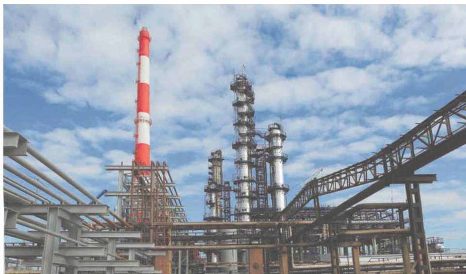
Строительство любого нового объекта начинается с осмечивания утвержденного проекта. На фото – установка изомеризации Орского НПЗ.
