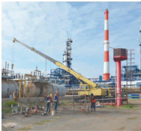
Специалисты ООО «Прометей» осуществляют монтаж переключающих устройств предохранительных клапанов
