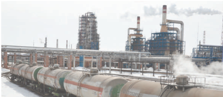
Фронт слива способен одновременно принять до 80 вагонов-цистерн
