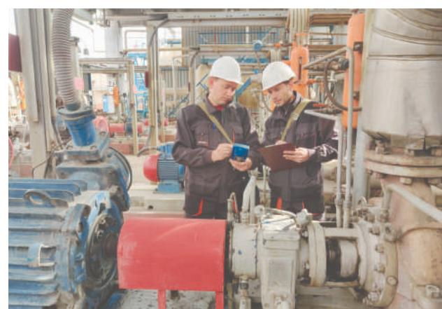
С.А. Ежов и И.С. Тужилин проводят контроль показаний параметров вибрации и ударных импульсов центробежного насоса БРР
