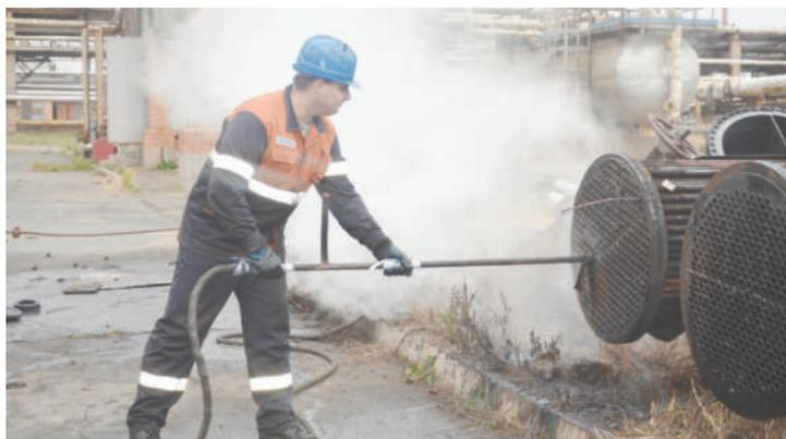
Оператор установки ЭЛОУ-АВТ-3 Г.С.Фатеев прочищает пучки технологического аппарата Т-1
