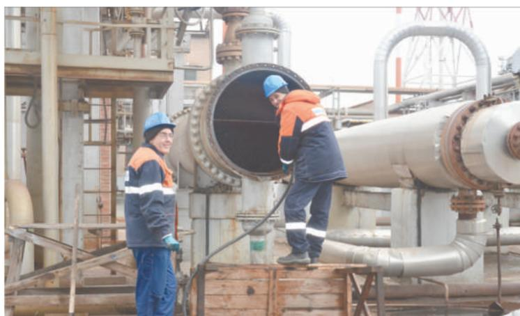
Машинисты компрессоров установки ЛГ-35-11-300/95 О.В.Федотов и М.В.Пролев промывают холодильное оборудование Х-1
