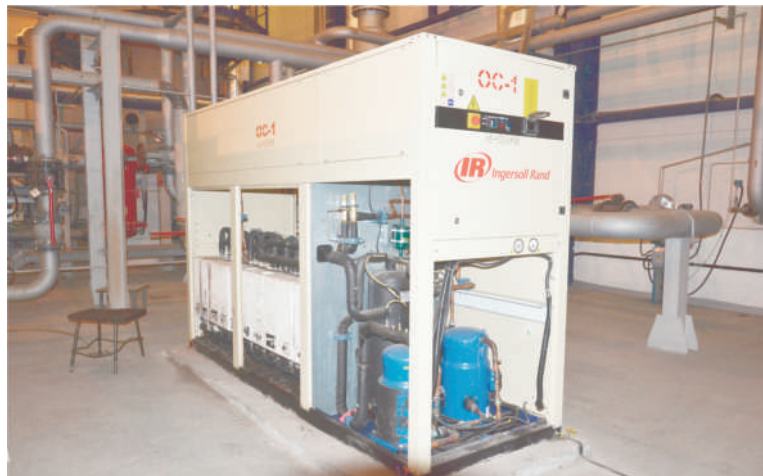
В ходе ремонта в рефрижераторном осушителе ОС-1 заменят испарительные модули
