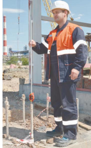
К.В.Михайлов фиксирует отражающую призму для определения точного положения анкерных болтов
