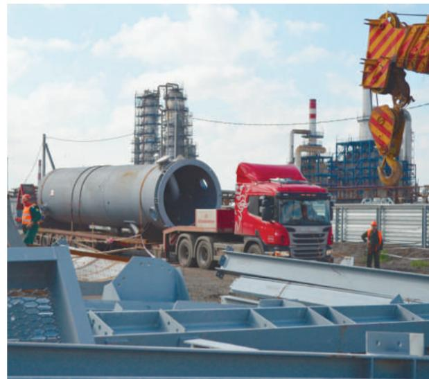
реакции гидрокрекинга будут протекать в реакторе Р-02. Оба аппарата произведены в Волгодонске филиалом ОА «АМ-технологии» «Атоммаш». На Орский НПЗ их привезли по железной дороге за 9 дней. Для достижения максимального транспортировочного веса реакторы доставили без нижнего штуцера и юбки.
