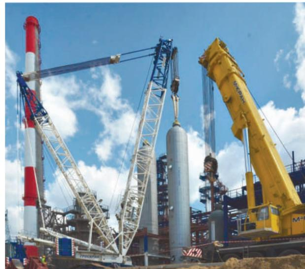
*Монтаж реакторов гидрокрекинга осуществили специалисты генерального подрядчика АО «Промфинстрой» при помощи уникальной системы Liebherr LR 1750/2 грузоподъемностью 750 тонн. Сборка самого подъемного механизма заняла более недели, при этом каждый из реакторов был установлен в проектное положение всего за 2,5 часа.*
