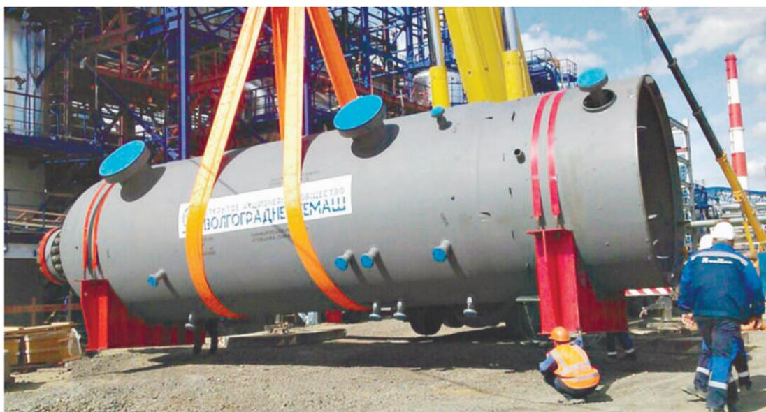
Монтаж холодного сепаратора высокого давления С-04, изготовленного ОАО «Волгограднефтемаш», в проектное положение установили специалисты АО «Промфинстрой». Он предназначен для работы в составе установки гидрокрекинга с секцией производства водорода.
