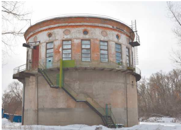
Высота насосной станции 16 метров, 3 метра уходят под землю
