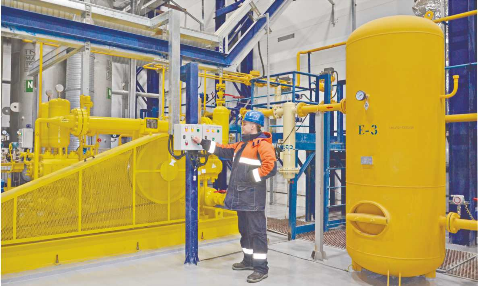
Сотрудники ПГВС изучают устройство азотной станции
