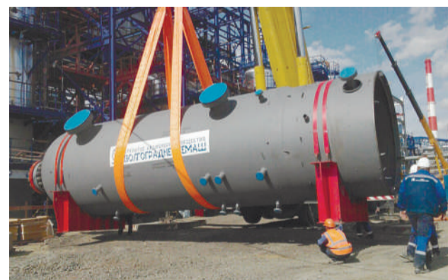
Холодный сепаратор высокого давления С-04 монтировали специалисты АО «Промфинстрой»
