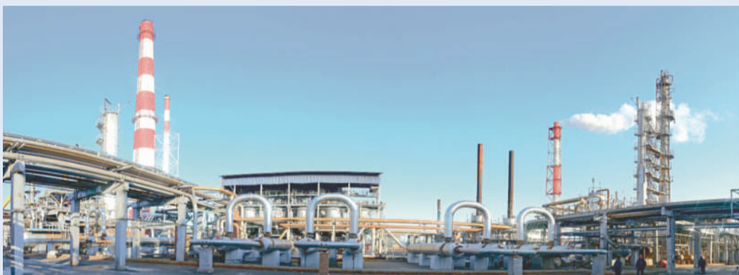
На Орском НПЗ установка каталитического риформинга ЛГ-35-11/300-95, которую мы привыкли называть 35-11-2, является одной из основных в технологической схеме предприятия. Предназначена она для получения из прямогонных бензиновых фракций компонента высокооктанового бензина. Введена в эксплуатацию в январе 1972 года. Производительность по сырью составляет 300 000 тонн/год. В 1998 году на установке была произведена реконструкция внутренних устройств реакторов блока риформинга, что позволило осуществлять выпуск высокооктановых неэтилированных бензинов.
