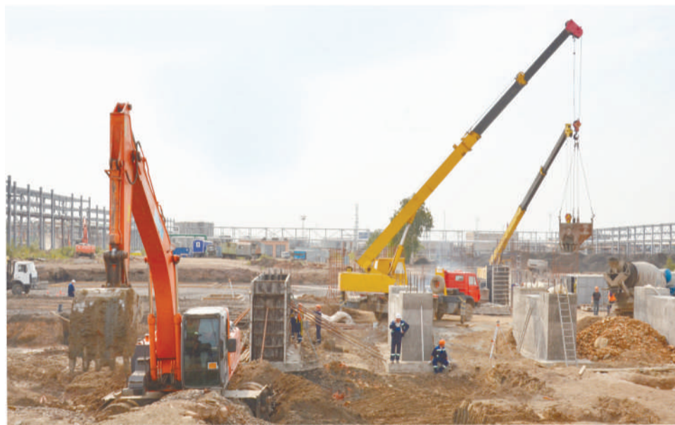
Строительная площадка установки вакуумной перегонки мазута
