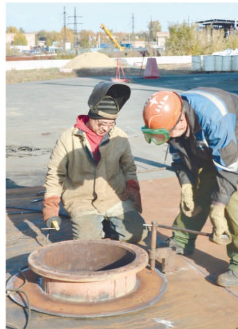
Специалисты ООО «Русич» монтируют штуцер на емкость Е-5
