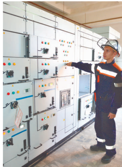
Монтаж силового оборудования проходил под контролем оперативного персонала электроцеха Орского НПЗ
