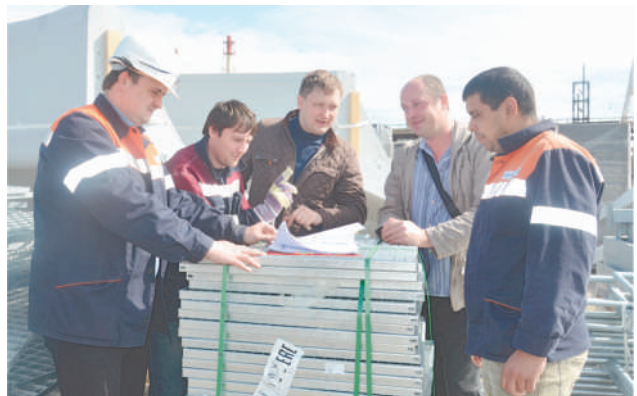
Специалисты группы входного контроля вместе с представителями компании-поставщика принимают трехсекционную градирню для установки гидрокрекинга
