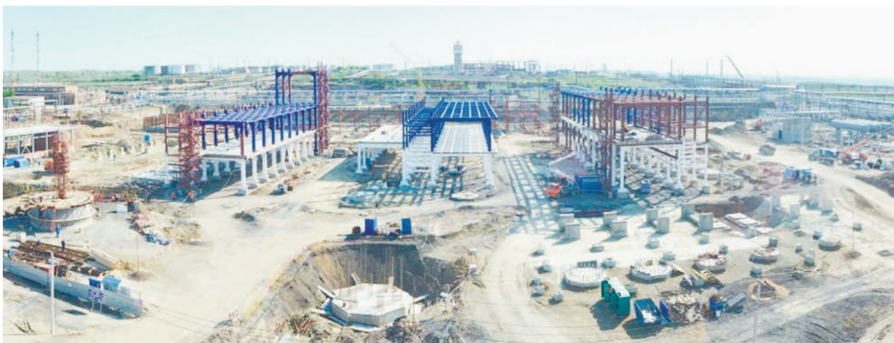
Панорама строительной площадки комплекса гидрокрекинга
