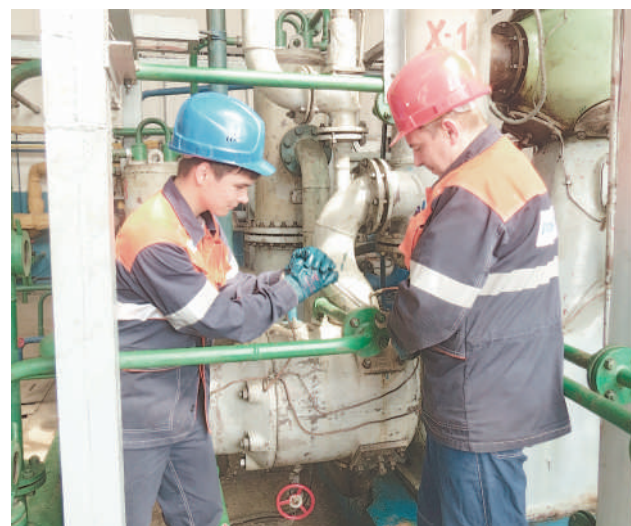
Механик установки А.В.Нагайцев и оператор А.Р.Алтыноманов производят монтаж трубопровода охлаждения поршневого компрессора ВК-1
