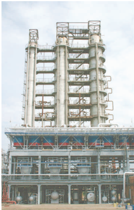
В процессе перегонки на нефтеперерабатывающих заводах при постепенно повышающейся температуре из нефти отгоняют части – фракции, отличающиеся друг от друга пределами выкипания. Этот процесс происходит в ректификационной колонне – специальном аппарате для разделения нефти на фракции.
