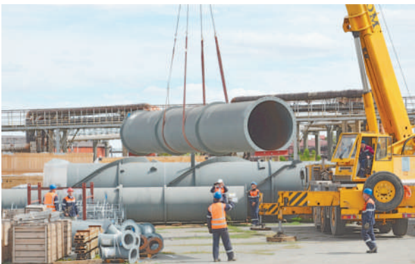
Разгрузка составных частей печи П1 для установки производства водорода
