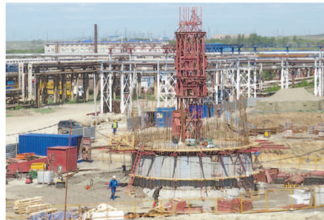
Возведение дымовой трубы
