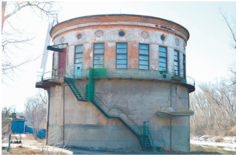
Сооружение насосной речного водозабора цеха ВиК
