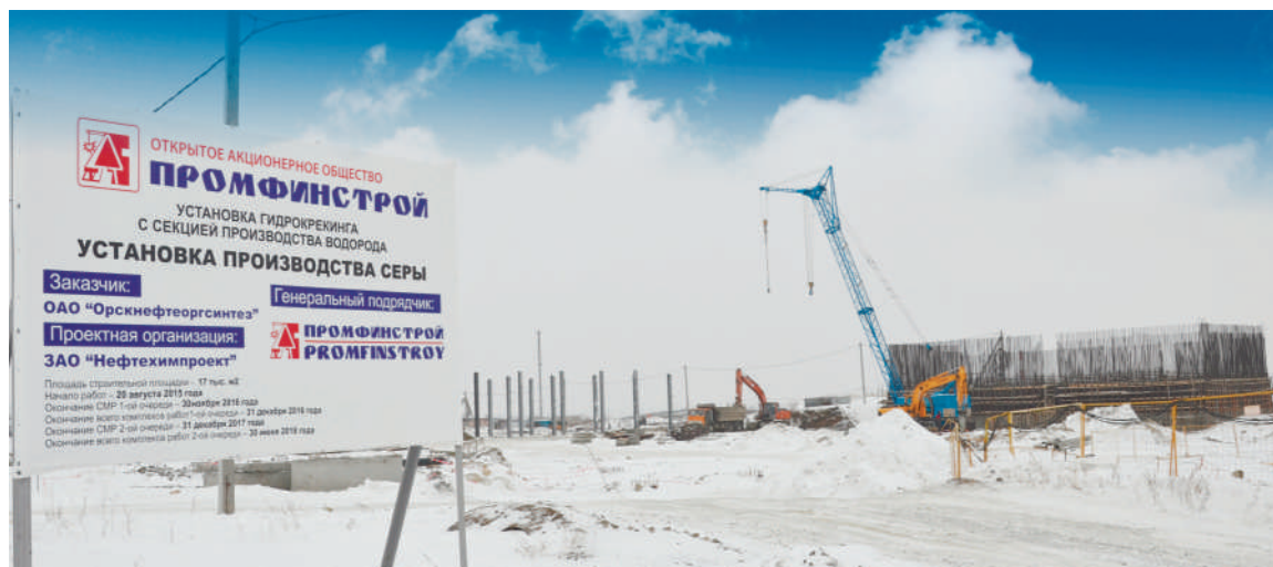
Все строительно-монтажные работы по комплексу проходят под руководством ген. подрядчика ОАО «Промфинстрой»
