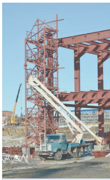
На площадке используется самое современное оборудование
