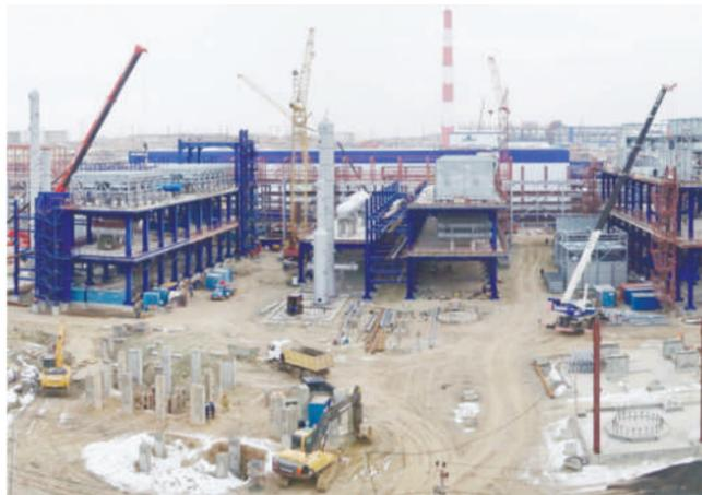
**С**амый крупный объект строительства этого года – Комплекс гидрокрекинга. Он является ключевым звеном Программы модернизации Орского НПЗ. В состав Комплекса, помимо самой установки гидрокрекинга с секцией производства водорода, входят установка производства серы с блоком грануляции и отгрузки, объекты общезаводского хозяйства. Все составля-
