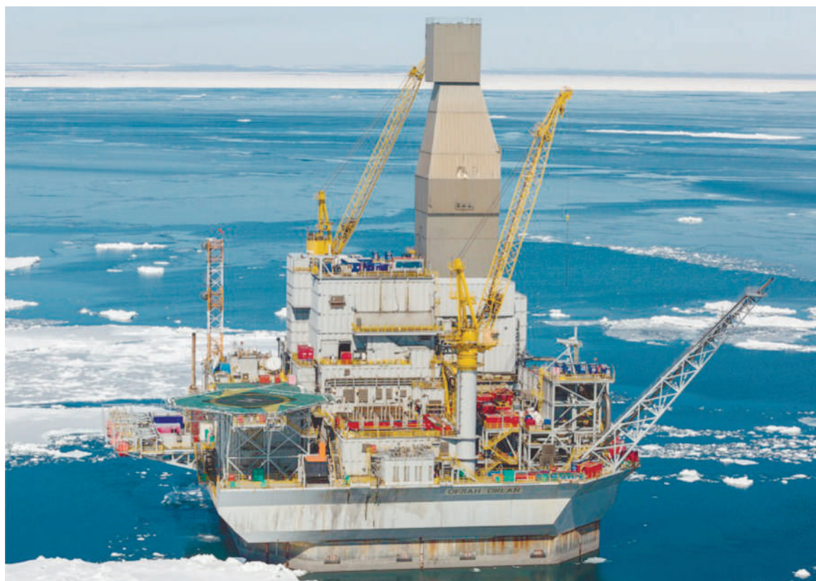
Эксплуатационная скважина О-14 пробурена в направлении крайней юго-восточной оконечности месторождения с буровой платформы «Орлан». Скважина имеет самую большую в мире глубину по стволу, равную 13 500 метров, и горизонтальный участок ствола длиной 12 033 метра
