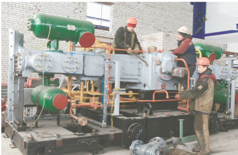
Смонтировано 20 единиц оборудования
