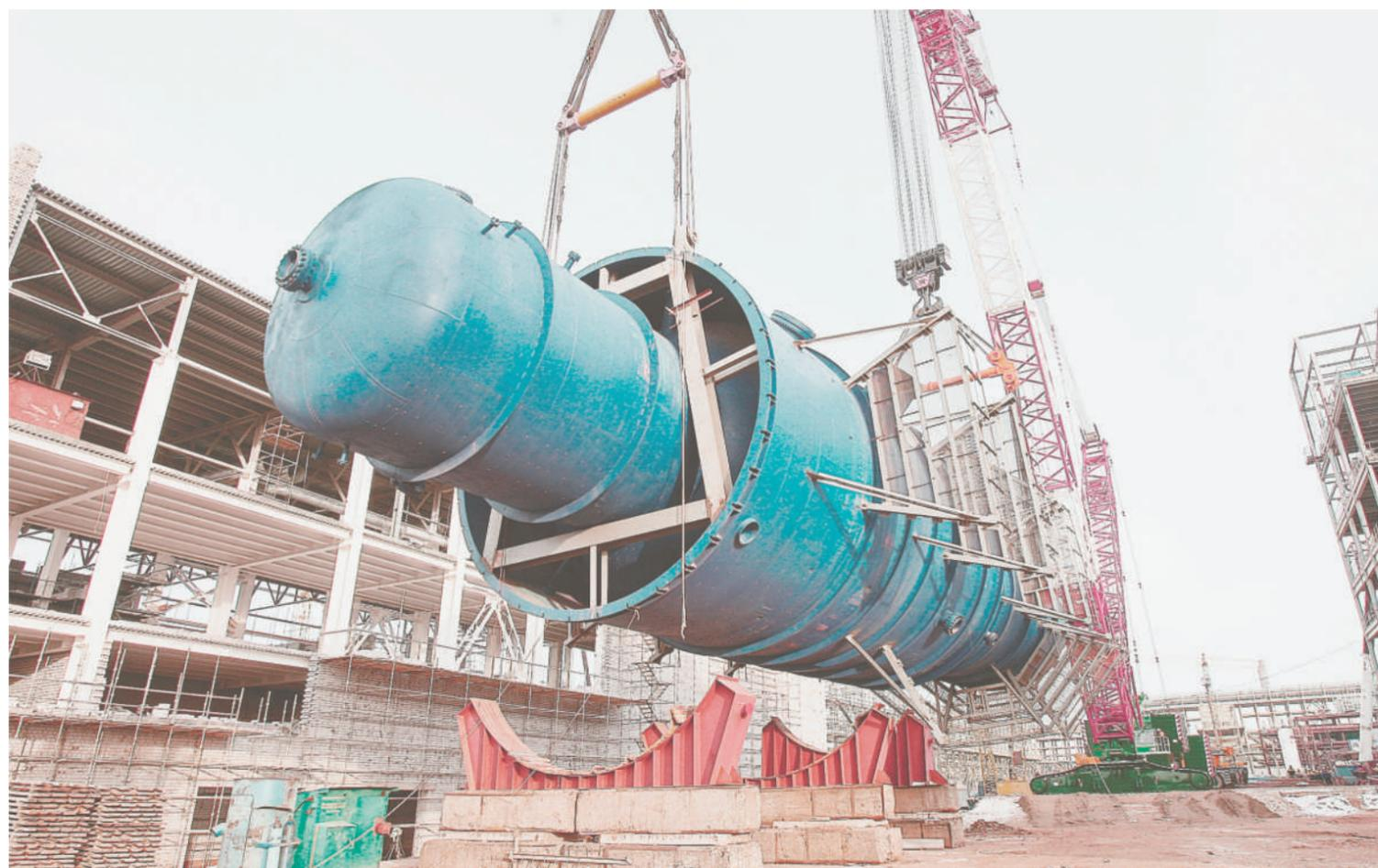
Монтаж колонны вакуумной перегонки мазута на крупнейшем нефтеперерабатывающем заводе Беларуси – Мозырском НПЗ
