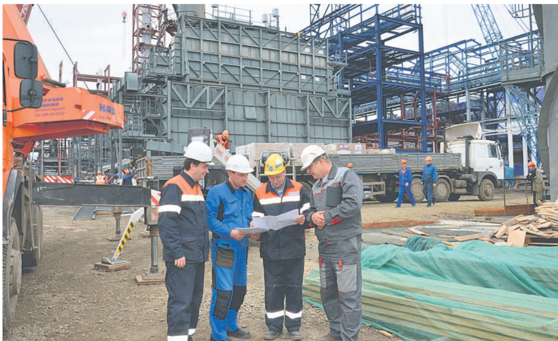
П.Симиони с помощью переводчика П.Щепотьева консультирует специалистов ООО «Промстроймонтаж» – старшего прораба О.А.Серебрякова и начальника участка Д.Г.Сырникова
