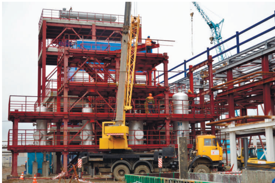
Монтаж металлоконструкций блока 003
