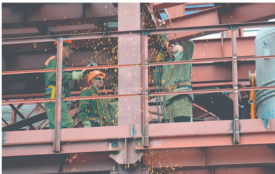
Специалисты ООО «УралПромСтрой» выполняют сварку металлоконструкций
