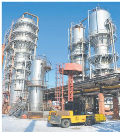
руют технологический процесс: температуру, количество кислорода и рециркуляра – той части битума, которая возвращается в процесс и используется для поддержания температуры. А также занимаются наливом и отгрузкой готового битума.
