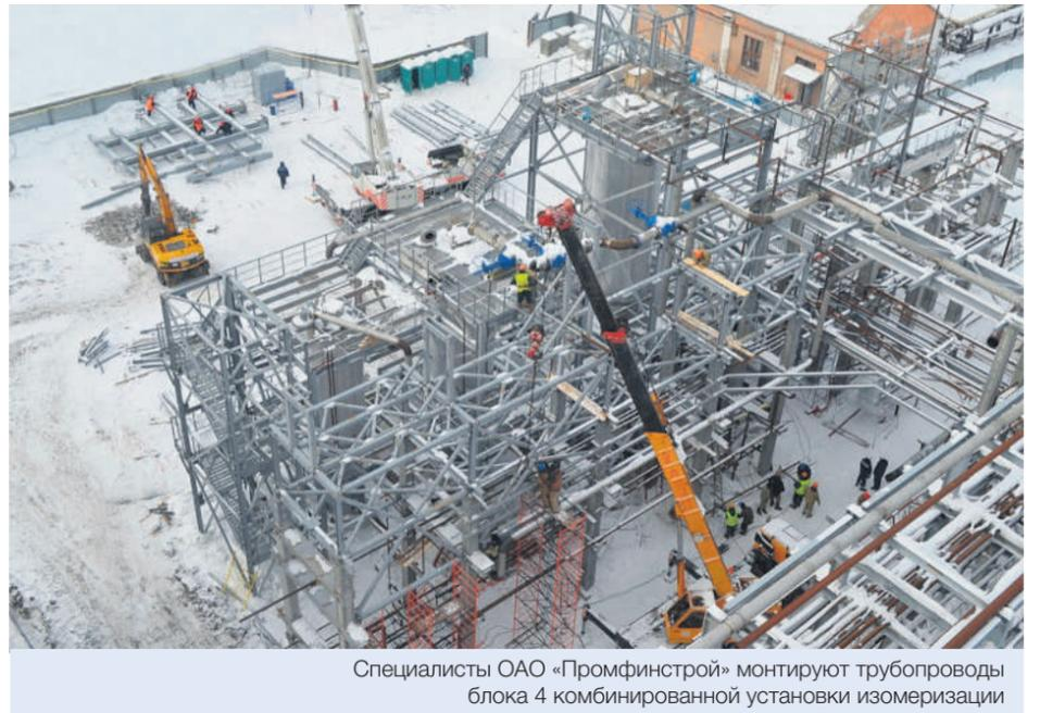
Специалисты ОАО «Промфинстрой» монтируют трубопроводы блока 4 комбинированной установки изомеризации
