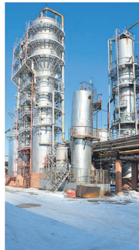
Окислительные колонны установки 19-6М по производству битума
