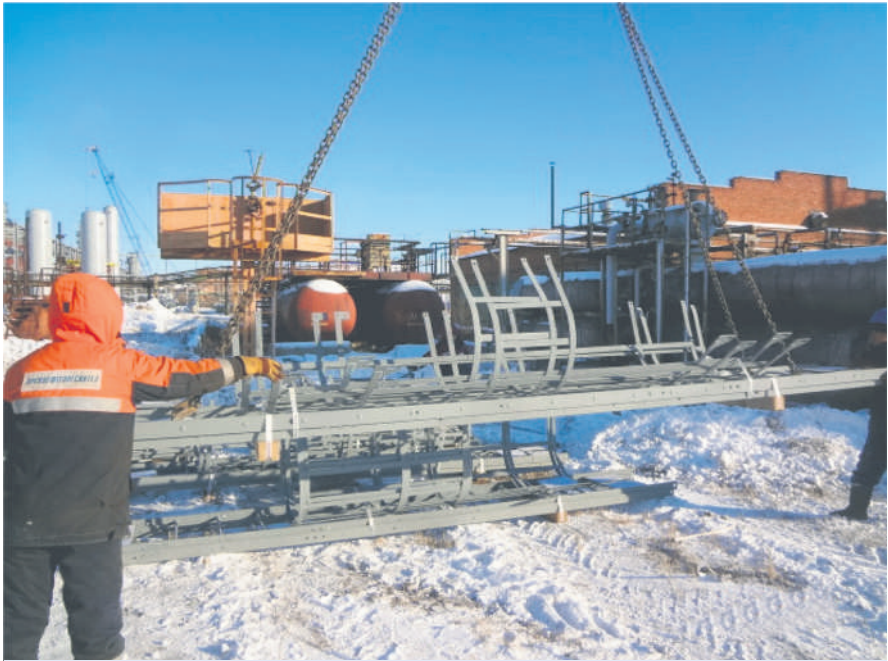
Сотрудники складского хозяйства осуществляют приемку конструкции печи для установки висбрекинга первой очереди поставки
