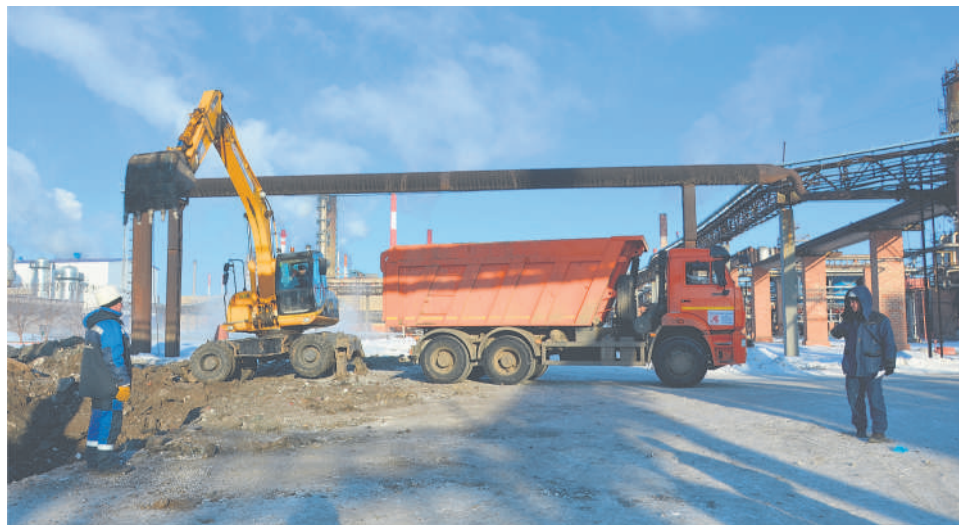
Специалисты ОАО «Промфинстрой» прокладывают новый магистральный участок промышленной канализации
