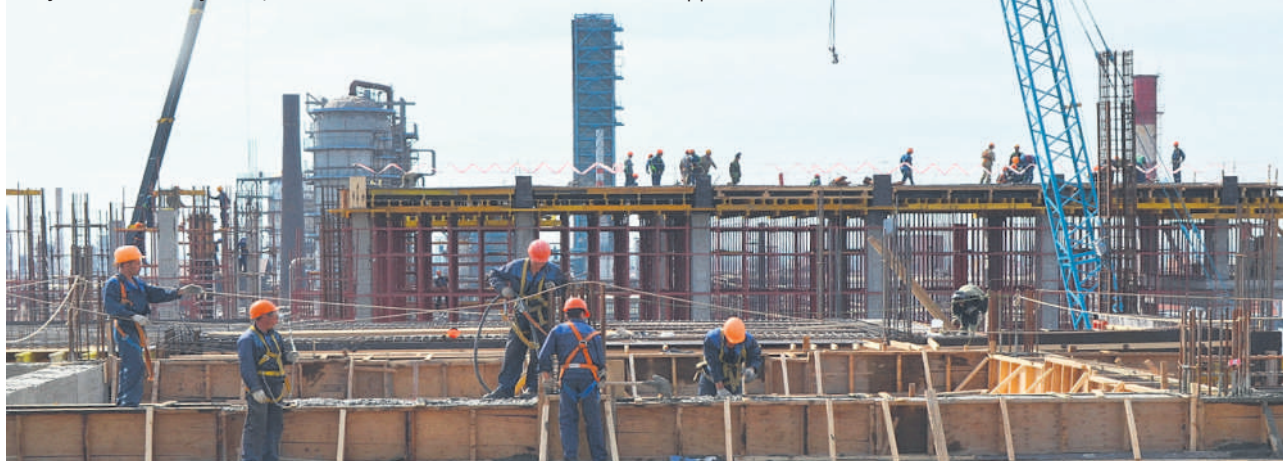
Специалисты ОАО «Промфинстрой» укладывают монолитные перекрытия комбинированной установки изомеризации с предварительной гидроочисткой сырья
