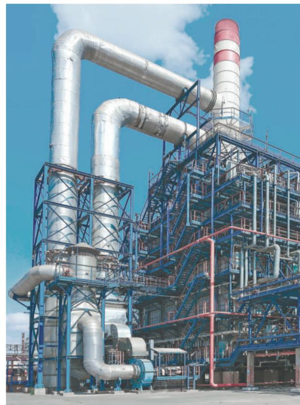
Установка ЭЛОУ-АВТ предназначена для подготовки и первичной переработки нефти с целью получения нефтяных фракций, различающихся по температуре кипения за счет процесса ректификации.
