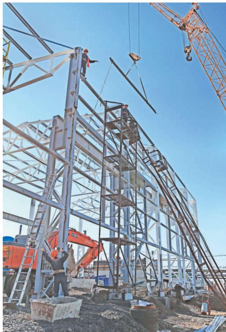
Специалисты генерального подрядчика ООО «Строймонтаж» возводят металлоконструкции здания компрессорной
