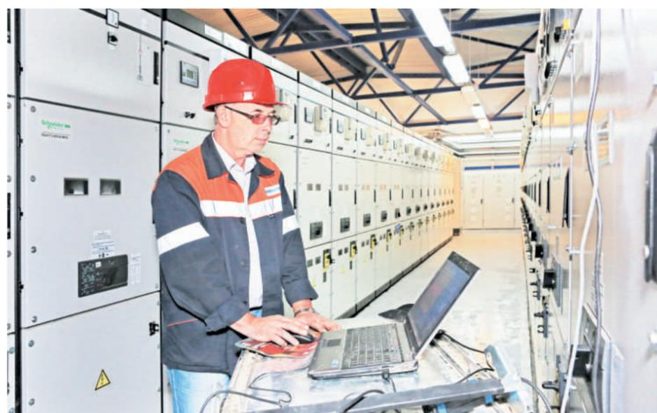
Старший мастер электроцеха И.В.Крэндиюков проводит проверку релейной защиты на базе микропроцессорной техники
