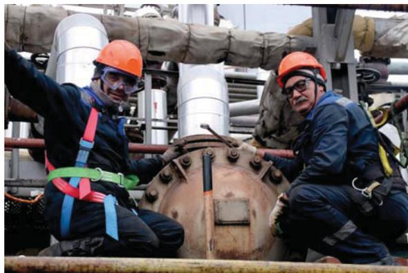
Работники подрядной организации «Уралпромстрой» выполняют вскрытие теплообменного оборудования для проведения чистки трубных пучков на установке ЭЛОУ-АВТ
