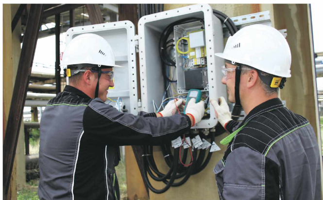
Сотрудники ООО «ТЕХНОПРОМ» выполняют пусконаладку системы видеонаблюдения
