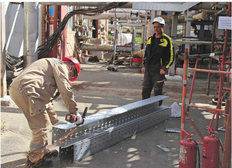
Сотрудники ООО «Промэлектроторг» выполняют замену лотков для кабелей КИП
