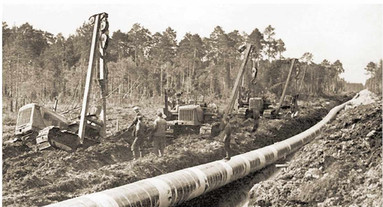
Строительство нефтепровода Шаим-Тюмень. 1962-1963 гг.
