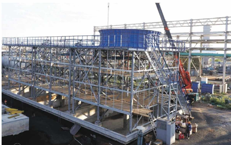
На водоблоке ведется монтаж трехсекционной градирни
