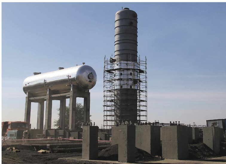
На УЗК выполнены работы по устройству фундаментов коксовых камер
