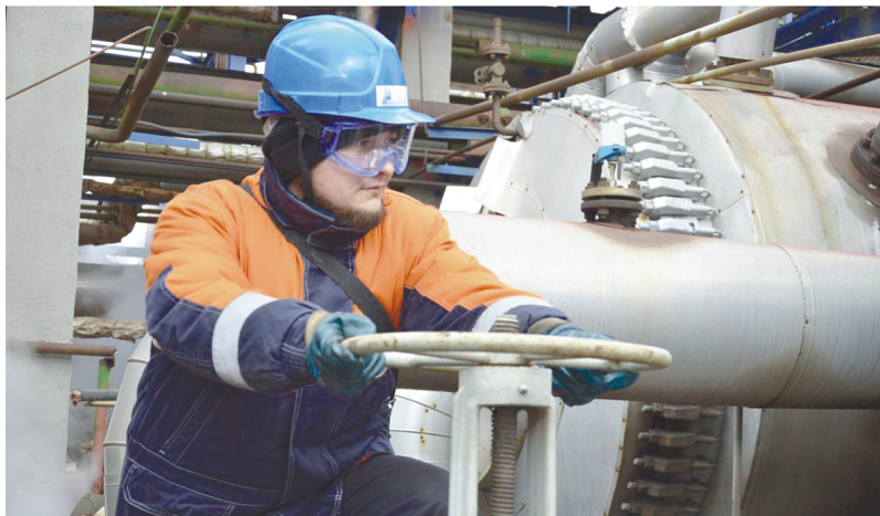
Оператор Максим Косынцев снимает неисправный вентиль на отглушенной линии
