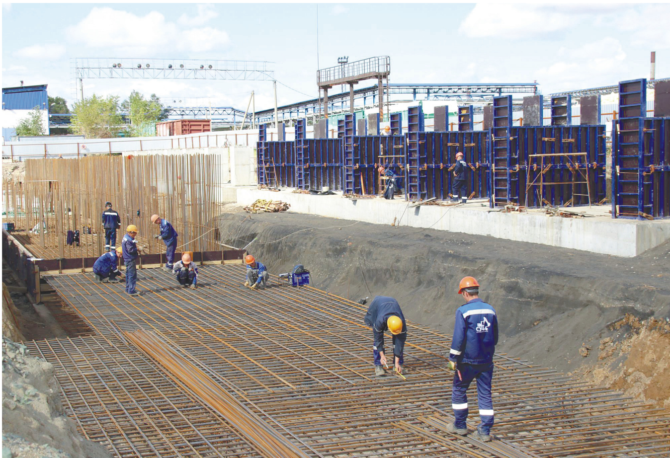
: Работники ООО «СУ-44» возводят фундамент эстакады слива вакуумного газойля
