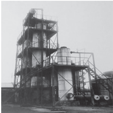
Установка В.Шухова для термического крекинга нефти, 1931 год
