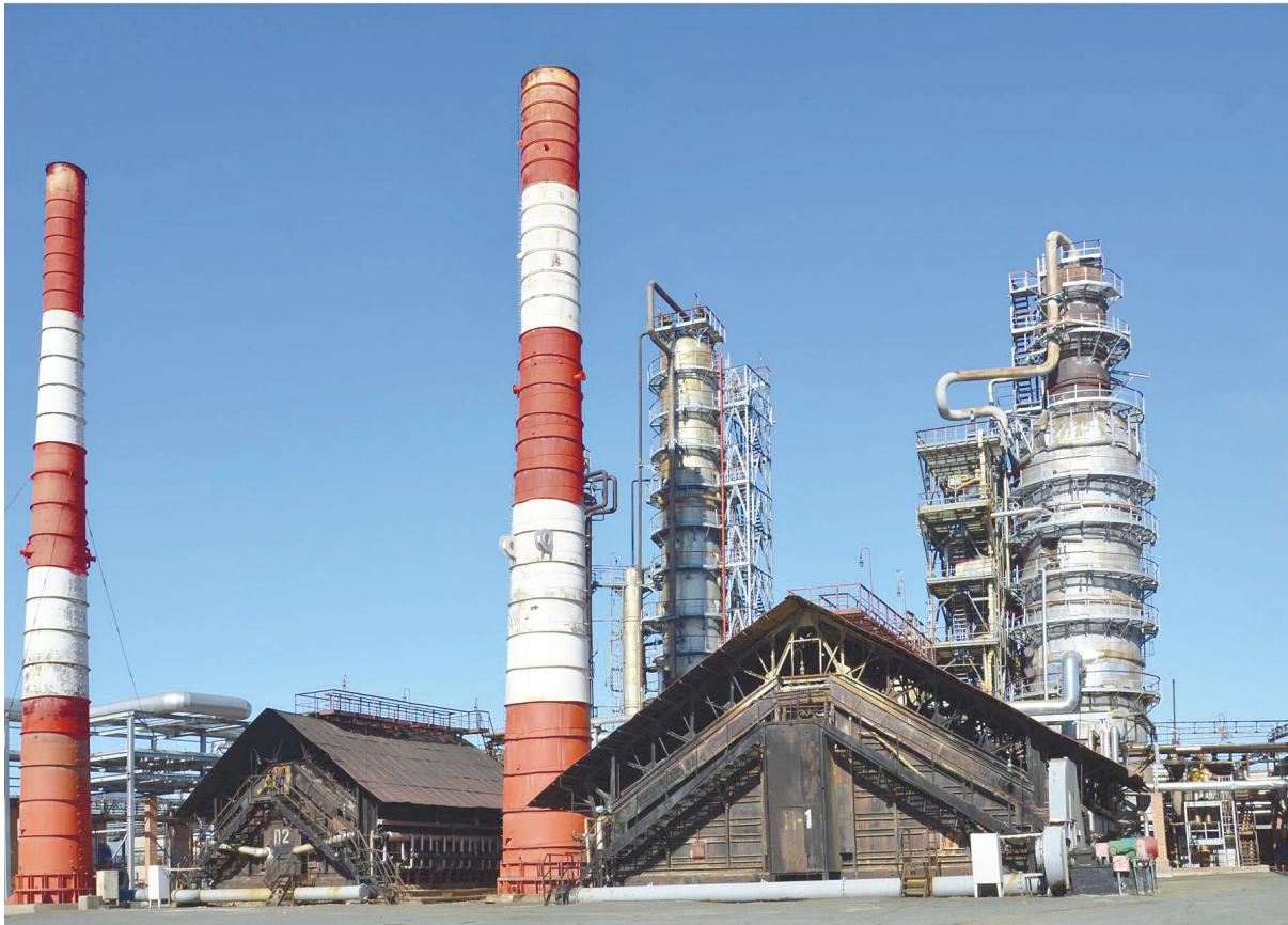
Одна из старейших установок ПАО «Орскнефтеоргсинтез» ЭЛОУ-АВТ-3 будет обновлена по программе технического перевооружения
