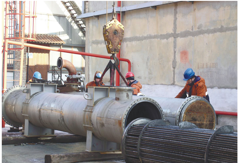
Сотрудники РМЦ осуществляют демонтаж и разборку теплообменного оборудования на установке Л-24-Т-6
