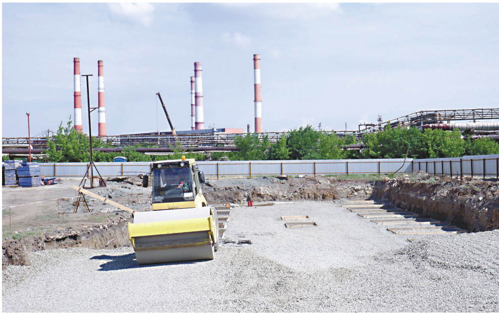
Строительная площадка эстакады слива вакуумного газойля
