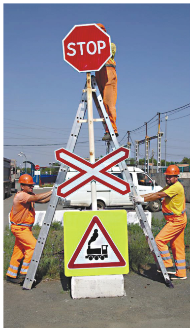
Сотрудники ООО «СП «Сигнал» устанавливают новый дорожный знак в районе КПП №4
