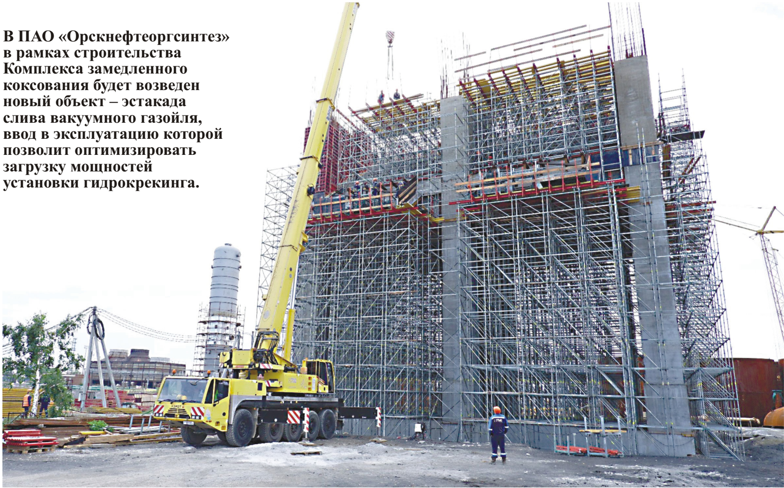
Строительная площадка установки замедленного коксования ПАО «Орскнефтеоргсинтез»
