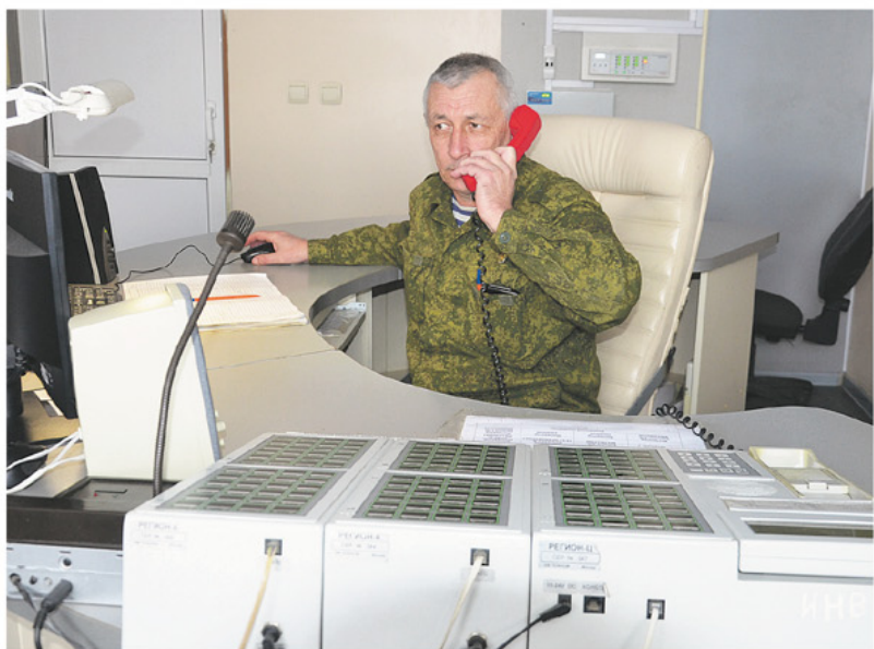
Диспетчер пункта связи пожарной части Е.Тюрин осуществляет проверку связи с охраняемыми объектами ПАО «Орскнефтеоргсинтез»
