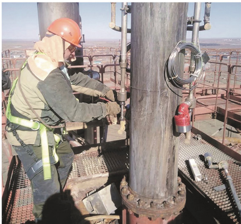
ООО НПП «Факел-Сервис» регулярно проводит ремонтные работы на факельных установках ПАО «Орскнефтеоргсинтез»
