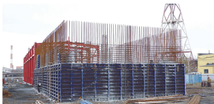
Строительная площадка эстакады слива вакуумного газойля (ВГО)
