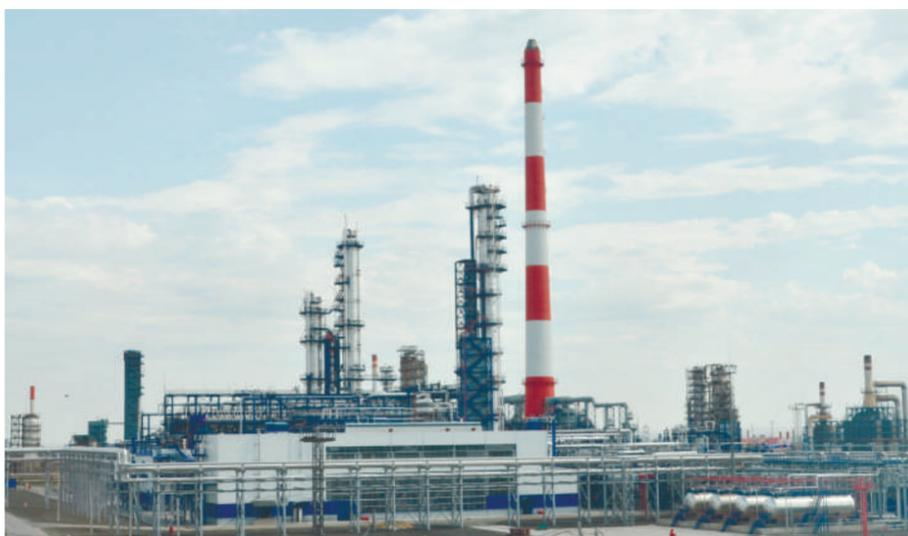
На большинстве установок Орского НПЗ имеются ректификационные колонны. Самые высокие из них расположены на установке изомеризации. Высота колонн здесь достигает 80 метров.
